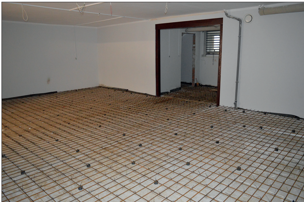
Ryc. 11. Czwarty etap prac remontowo-adaptacyjnych magazynu archeologicznego MAH w Stargardzie, wg stanu z 27 października 2017 r. Fot. A. Bierca, MAH w Stargardzie
