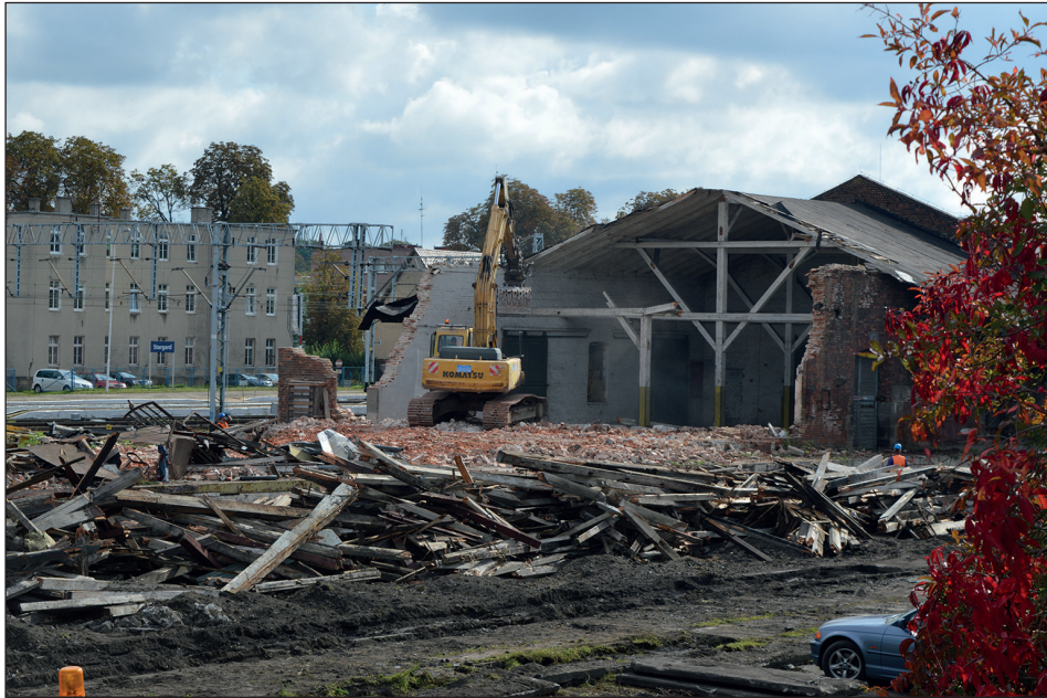
Ryc. 9. Prace rozbiórkowe budynku przy ul. Zwycięzców w Stargardzie, wg stanu z 27 czerwca 2017 r. Fot. A. Bierca, MAH w Stargardzie
