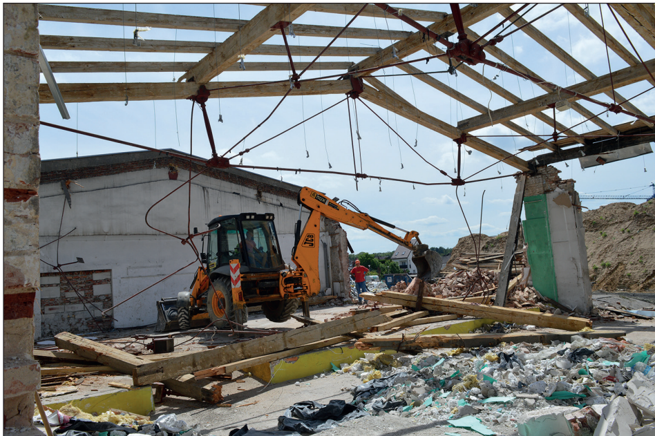
Ryc. 10. Prace rozbiórkowe zabudowy kolejowej pomiędzy dworcem a ulicą Towarową poprzedzające budowę Zintegrowanego Centrum Przesiadkowego w Stargardzie, wg stanu z 22 września 2017 r. Fot. A. Bierca, MAH w Stargardzie
