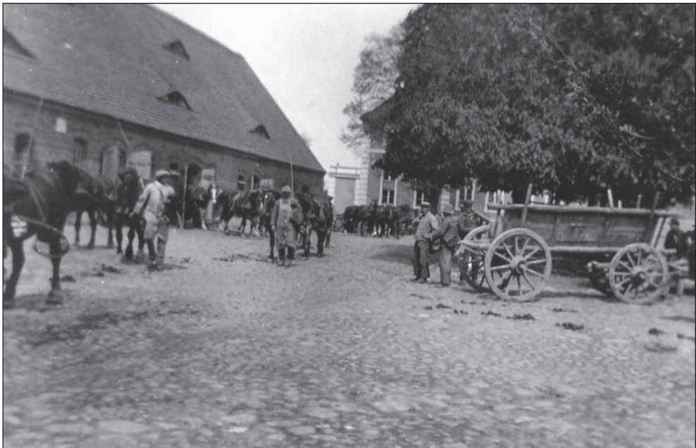
Ryc. 2. Zabudowa gospodarcza i pracownicy majątku rodziny Stegmann-Stein w Rzeplinie (do 1945 r. Repplin), gmina Dolice lata 1935–1936. Fotokopia w zbiorach Działu Dokumentacji Zabytków MAH w Stargardzie
